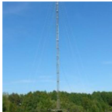
Upprättad mast.(Foto processmekanik)
